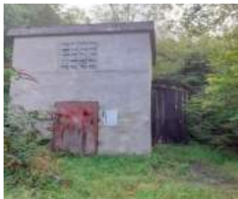
Réservoir de la captation de la Hount
