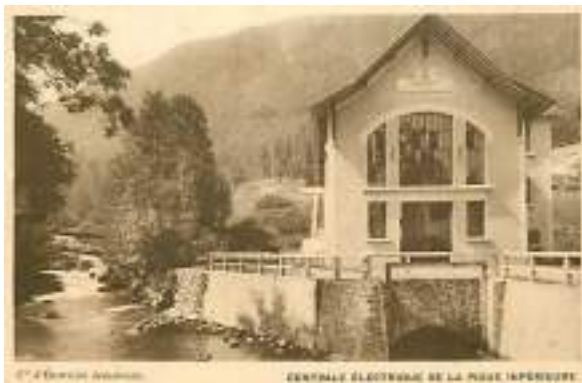
Centrale de la Pique inférieure
